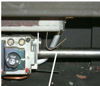
*Tige de réglage : Pousser pour fermer ou tirer pour ouvrir le capuchon d'arrivée d'air.*
