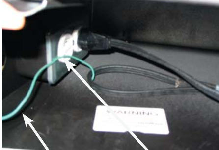
Fils de terre la boîte de prise de courant
