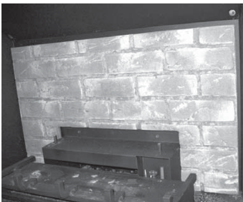
panneau du fond installé
