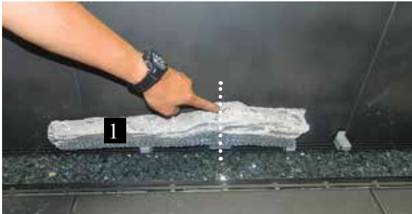
Aligner le noeud au centre de la coiffe de la veilleuse
