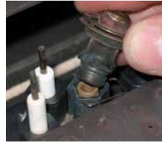
16. Dévisser l'orifice de la veilleuse à l'aide d'une clé hexagonale Allen; puis le remplacer par l'orifice de la veilleuse et le capuchon de la veilleuse, pour propane fournis dans la trousse.
