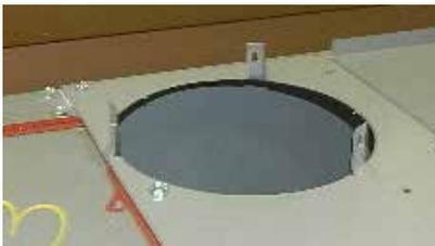
4. Connecter l'adaptateur du conduit à l'aide de 3 vis (utiliser les trous inférieurs situés sur l'adaptateur).
