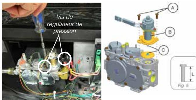
9. Rebrancher le câble du régulateur de pression qui a été débranché à l'étape 6 et replacer le module IFC en installant les vis qui maintiennent les ferrures de montage du module IFC.
