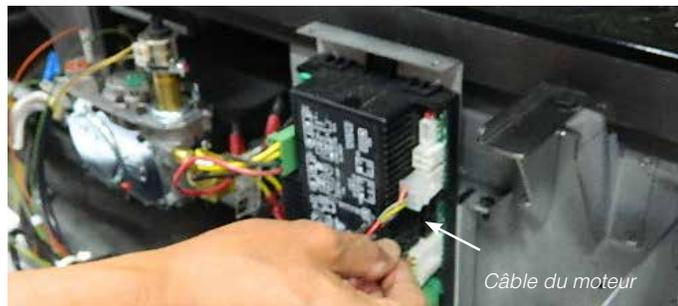
6. Si l'accès au câble est impossible, desserrer les 2 vis qui maintiennent le module IFC et le glisser hors de l'appareil pour accéder au câble.
