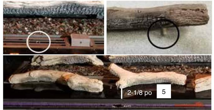
11. Insérer la tige de la bûche 6 dans le trou sur le côté droit de la veilleuse. Placer l'extrémité droite de la bûche 6 à 2 po du bord du panneau.
