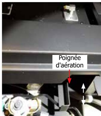
**Remarque :** La poignée d'arrivée d'air se trouve à la droite de la trappe d'accès de la valve de gaz. Elle est maintenue par un aimant.
