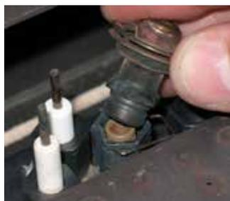
15. Dévisser l'orifice de la veilleuse à l'aide d'une clé hexagonale Allen; puis le remplacer par l'orifice de la veilleuse et le capuchon de la veilleuse pour propane fournis dans la trousse.
