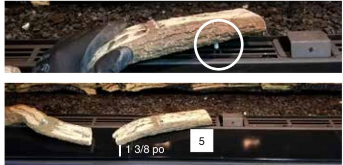
11. Insérer la tige de la bûche 6 dans le trou sur le côté droit du pilote. Placez l'extrémité gauche de la bûche 6 à 3/4 po du bord du panneau.
