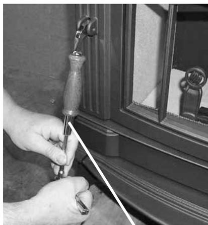
Fixer la poignée à l'aide d'une clé à douilles de 7/16 po.
