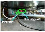
Brancher les raccordements (noir et rouge) du fil gris du ventilateur aux raccordements IFC (noir et rouge).
