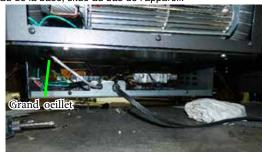
7. Faire passer le fil gris du ventilateur dans le petit œillet du câble d'alimentation, de la plaque de couverture de la valve jusqu'au panneau de la base, en passant par le grand œillet.
