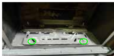
Retirer les 2 vis, pousser le dispositif du brûleur vers la gauche puis le soulever.
