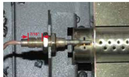
Schéma 4 - Position correcte du thermocouple
