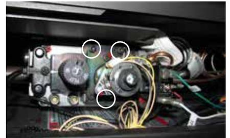
Enlever le moteur pas-à-pas pour gaz naturel et le remplacer par le moteur pas-à-pas pour propane
