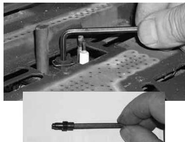
12. Retirer l'orifice du brûleur avec une clé de 1/2 po tout en utilisant une clé de 9/16 po pour maintenir le coude à l'arrière de l'orifice, puis mettre l'orifice au recyclage.
