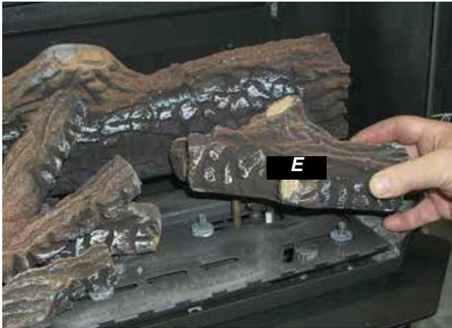
7. Placer l'entaille située sur la bûche centrale F par-dessus la bûche E et en travers de l'encoche située sur la bûche A.
