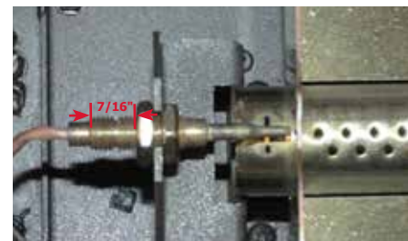
Schéma 4 - Position correcte du thermocouple
