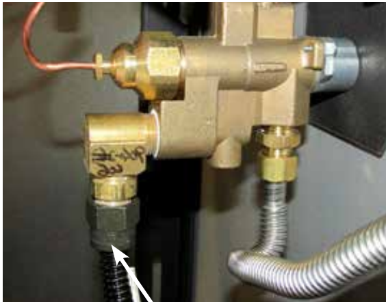
Brancher la conduite flexible à la valve Schéma 15
