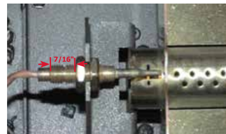
Schéma 4 - Position correcte du thermocouple
