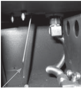
Le tige de débit d'air - située à gauche de la soupape.
