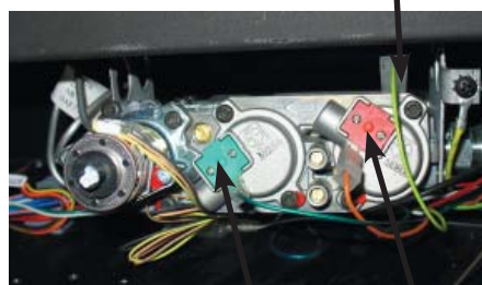
Schéma 1: Dévisser les deux vis du brûleur.
