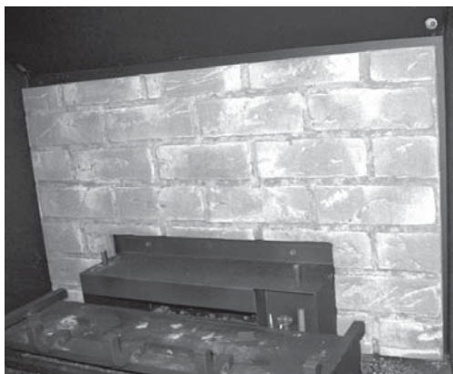
panneau du fond installé
