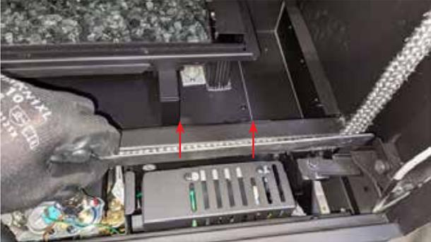
3. Repérer les 2 vis sur le couvercle du panneau IFC et retirer le couvercle pour accéder au panneau IFC.
