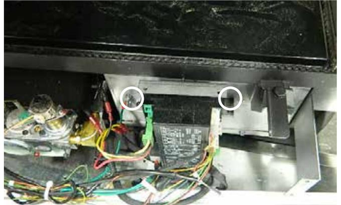
7. Retirer et mettre de côté les 2 vis du régulateur de pression A à l'aide d'un tournevis T20 ou à fente, le régulateur de pression B, le ressort et le diaphragme C.
