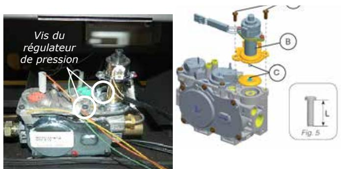
9. Rebrancher le câble du régulateur de pression qui a été débranché à l'étape 6 et replacer le module IFC en installant les vis qui maintiennent les ferrures de montage du module IFC.
