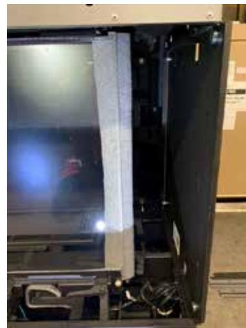
2. Installer le guide de bordure de finition pour l'installation à gauche ou à droite sur le panneau latéral externe.
