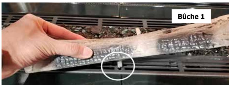
7. Poser la bûche sur la chambre de combustion. Veiller à ce que l'extrémité inférieure gauche de la bûche soit à 7/8 po du bord de la chambre de combustion.
