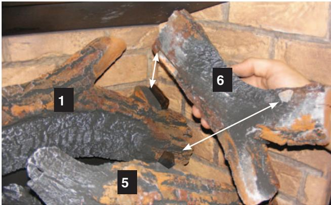
12) Assurez que le "Y" bas de bûche 6 est correctement placé sur la disposition sur la bûche 5 - voir ci-dessous.
