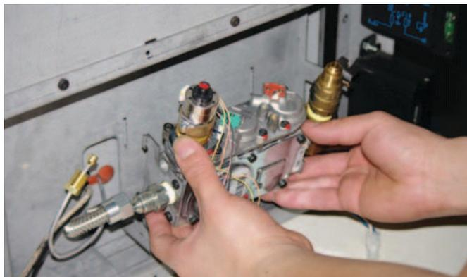
99) Placer la soupape dans un étau, en la fixant au niveau du coude à 90 degrés, et séparer ces deux éléments à l'aide d'une clé à molette.
