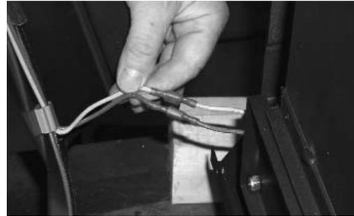
Connect the fan wires.
