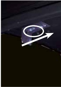
Schéma 64 : Attache pour panneau de briques
