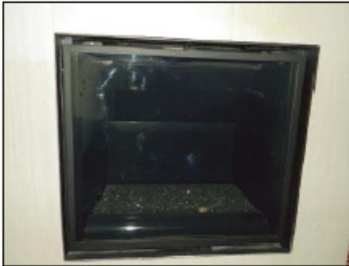
Schéma 83 : Cadre fixé à l'appareil
