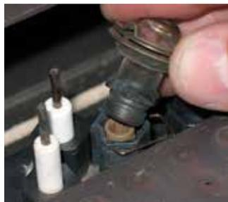
15. Dévisser l'orifice de la veilleuse à l'aide d'une clé hexagonale Allen; puis le remplacer par l'orifice de la veilleuse et le capuchon de la veilleuse pour propane fournis dans la trousse.
