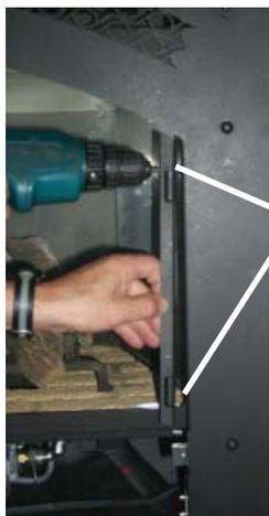
ferrures de porte *attache* avec 2 vis sur chaque côté
