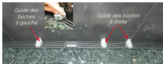
Guides des bûches installés
