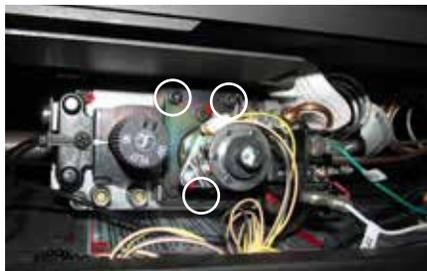
Retirer le moteur pas-à-pas pour gaz naturel et le remplacer par le moteur pas-à-pas pour propane.
