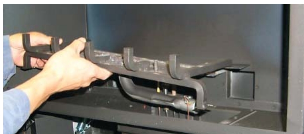
Schéma 1: Dévisser les deux vis de chaque côté du brûleur et le soulever.
