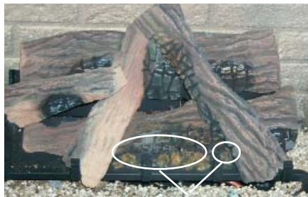
Déposer les morceaux de laine minérale ici.
