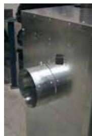
Centrer le collet du conduit rond sur le trou et le fixer aux languettes à l'aide de 3 vis.
