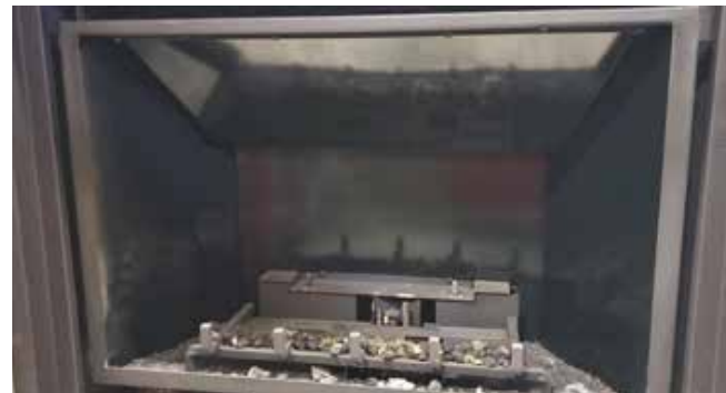
Schéma 7 - Installation complète des panneaux
