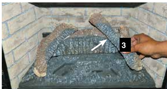
Installation de la bûche 3
