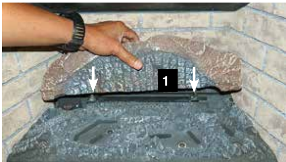
Installation de la bûche 1
