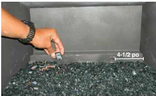
Installation de la fixation pour les bûches
