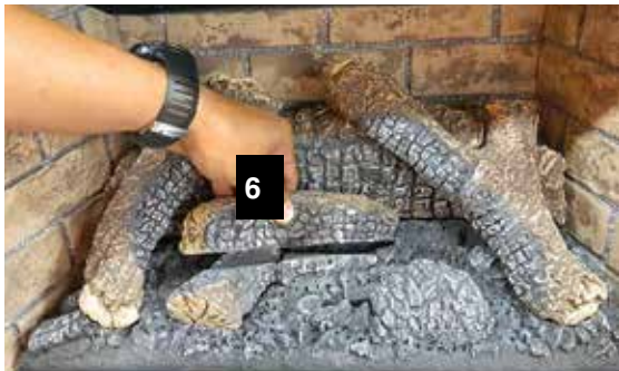
Installation de la bûche 6
