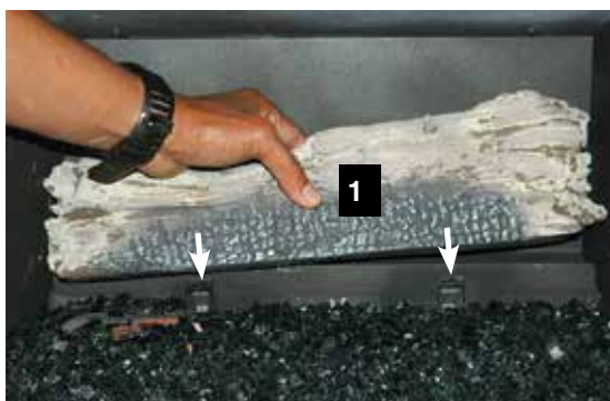
Installation de la bûche 1
