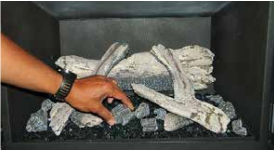
Installation des braises
