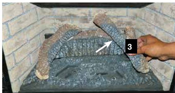
Installation de la bûche 3
