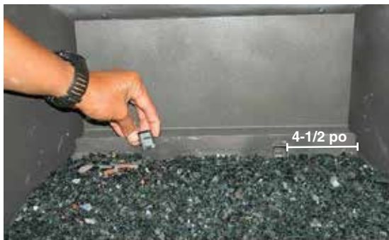
Installation de la fixation pour les bûches
