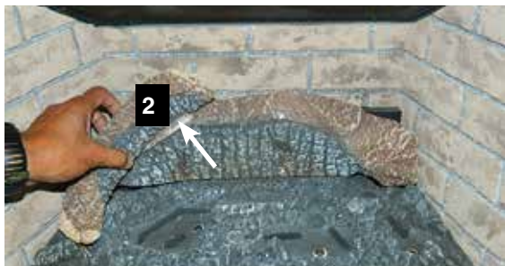
Installation de la bûche 2
