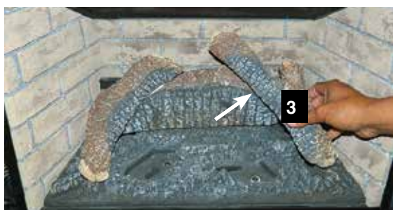
Installation de la bûche 3
