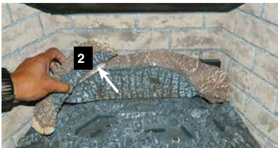
Installation de la bûche 2
