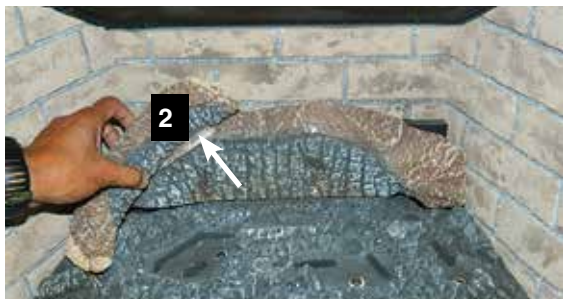
Installation de la bûche 2
