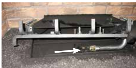
Schéma 2 : Glisser le brûleur vers la droite puis le soulever
