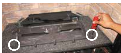
Schéma 1 : Dévisser les deux vis du brûleur.
