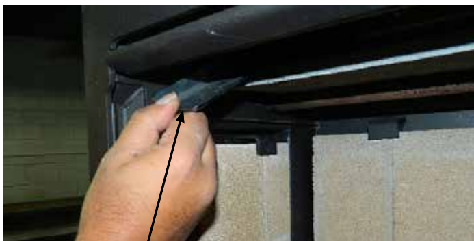
Plaque de recouvrement du déflecteur
