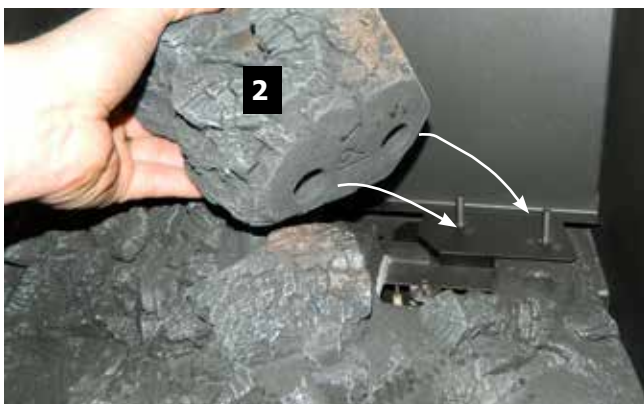
Aligner les trous de la bûche 2 sur les tiges du brûleur
