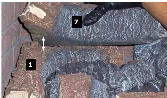
Trou de la bûche 7 à aligner avec la tige de la bûche 1
