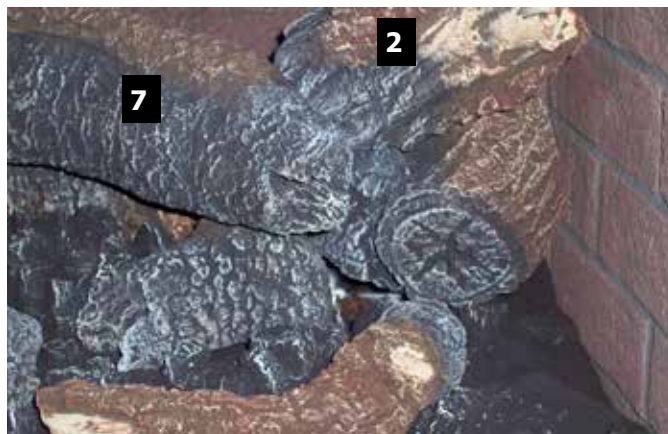
Les bûches 7 et 2 doivent être en contact
