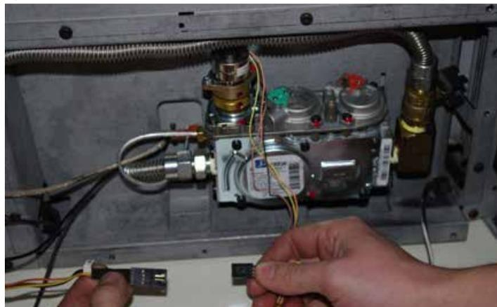
4) Enlever et jeter les 2 vis A (T20 ou à fente) du régulateur de pression, le régulateur de pression B, le ressort et le diaphragme C.
