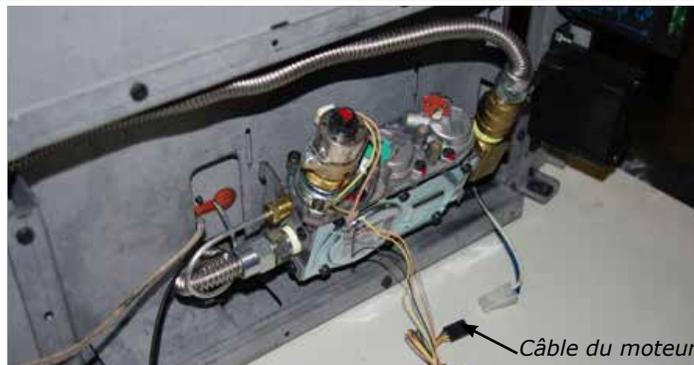
3) Débrancher le câble en provenance du moteur de régulation de pression.
