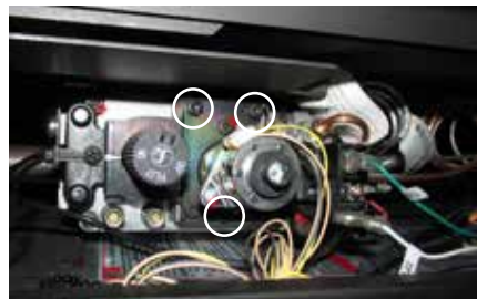
Retirer le moteur pas-à-pas au gaz naturel et le remplacer par le moteur pas-à-pas au propane
