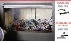
1) Lorsque l'appareil et la cheminée ont atteint une température fonctionnelle, le processus de remplissage devient plus rapide. Pour relancer le cycle de combustion à son terme, éteindre le ventilateur avant d'ouvrir la porte et étendre les tisons à l'aide d'un tisonnier.
