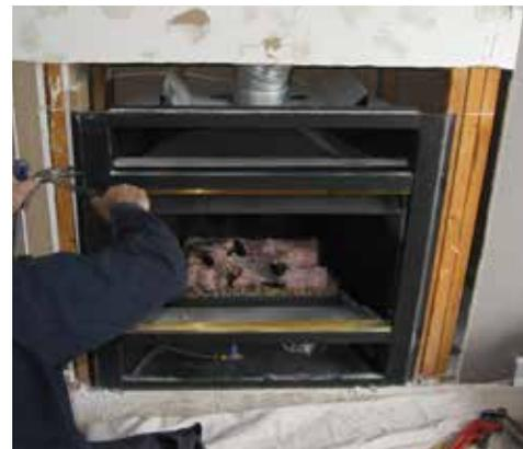
*Retirer l'appareil de la structure d'encadrement*
