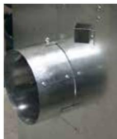
Centrer le manchon circulaire du conduit sur le trou et le fixer aux languettes à l'aide de 3 vis
